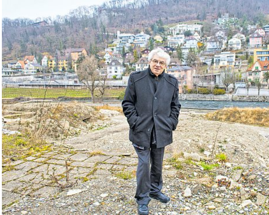
Mario Botta a Baden, dove il 5 marzo sono iniziati i lavori per la costruzione del nuovo stabilimento balneare.
